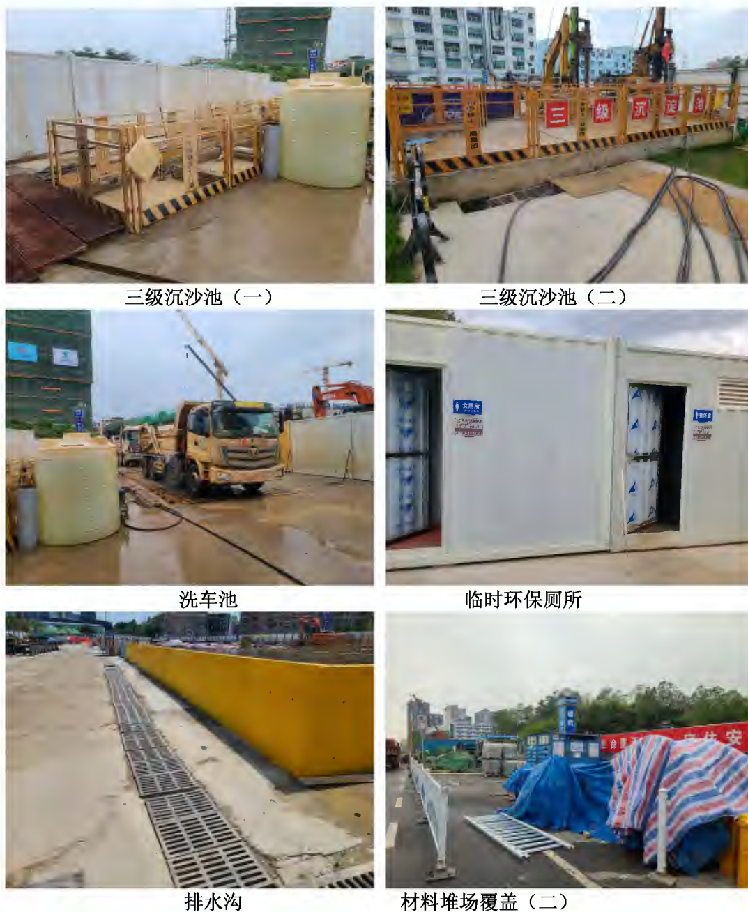
图 5.4-1 施工期水污染防治措施
