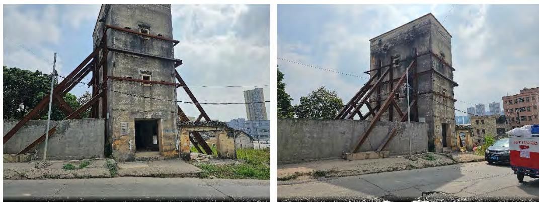
坪西萧氏炮楼楼体钢结构加固支撑
