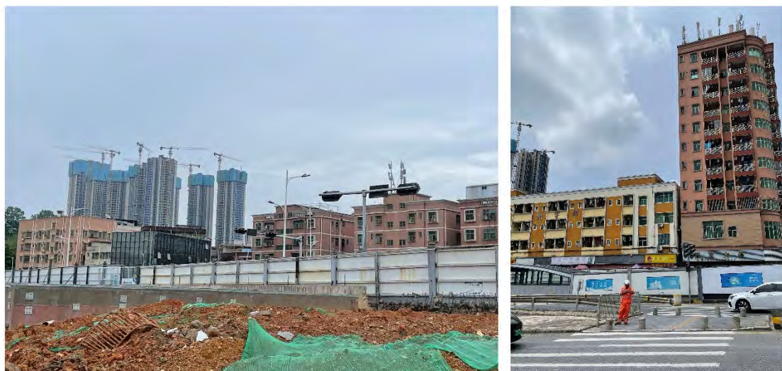
图 5.2-1 施工期降噪措施（施工围挡）
