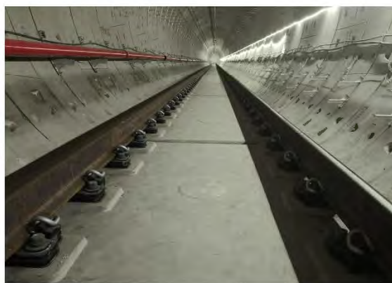
中等减振预制板整体道床
