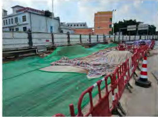
裸露地表覆盖
