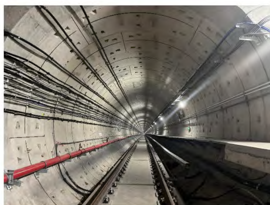
高等减振预制板整体道床
