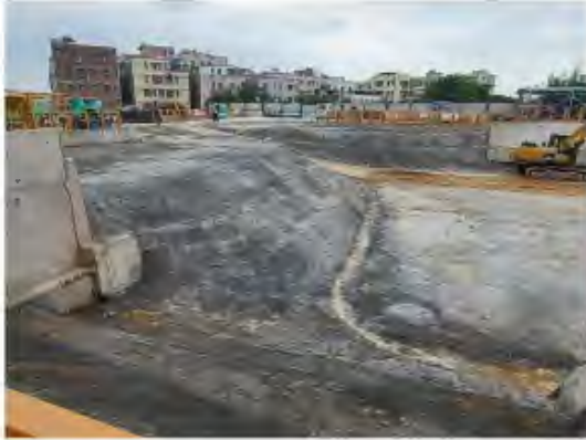
施工期临时地表硬化
